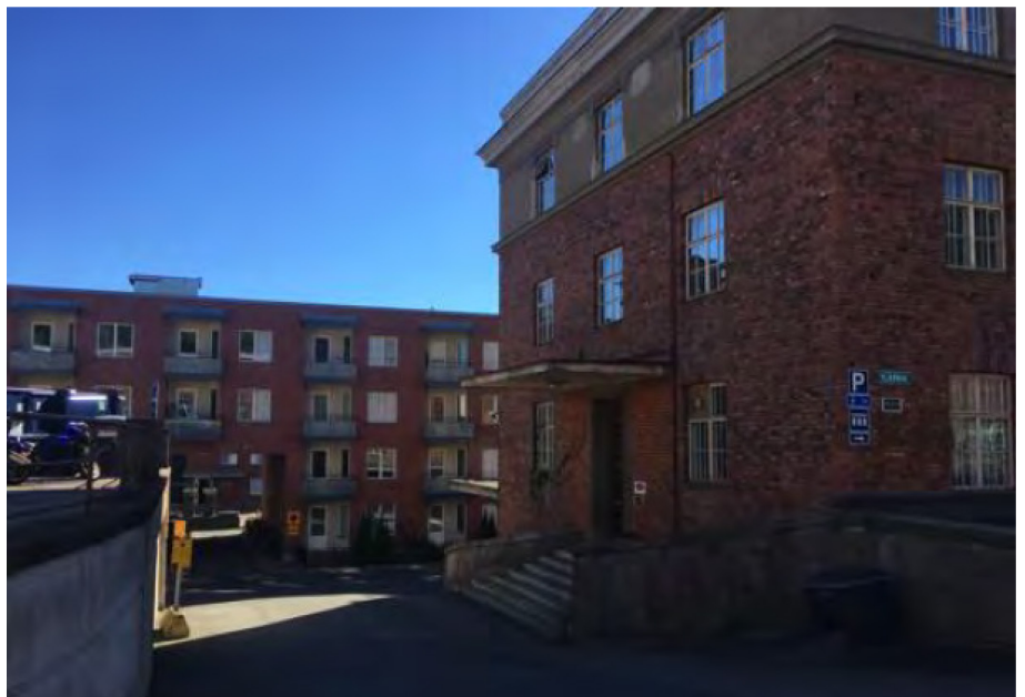
Konttori 215 rakennusvuosi on 1927. Sisustus ja sisäänkäynti ovat vuodelta 1937. Päädyn sisäänkäynti pyöristyvine tukimuureineen on tärkeä ulkotilan elementti. Kuva Arkkitehtitoimisto B&M.
